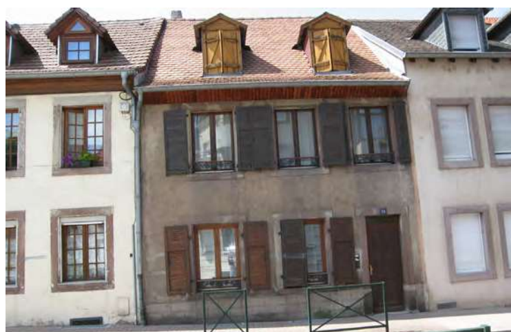
n°20 rue du Bac : volets battants sur les lucarnes, à persiennes à l'étage et mixtes au RDC.
