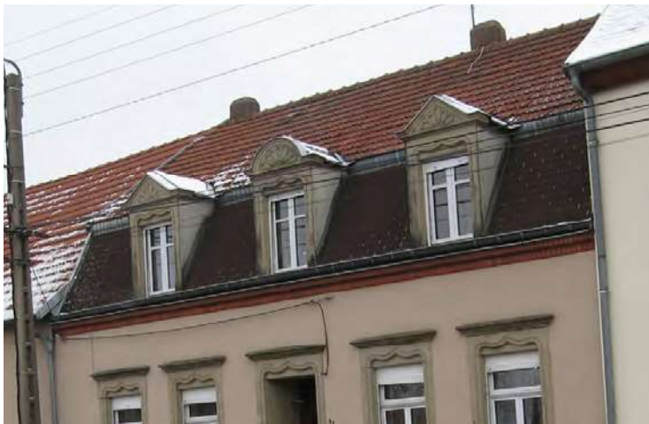
n°2 rue de Deux-Ponts : lucarnes à frontons (triangulaires et cintré) en pierre, d'origine, à conserver.
