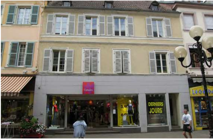
n°9 rue Sainte-Croix (devanture en applique contemporaine) : la seconde entrée permettant d'accéder aux étages a été conservée et l'éclairage des vitrines se fait pas l'intérieur. Il manque une rampe PMR (obligation d'accessibilité d'ici 2015).
