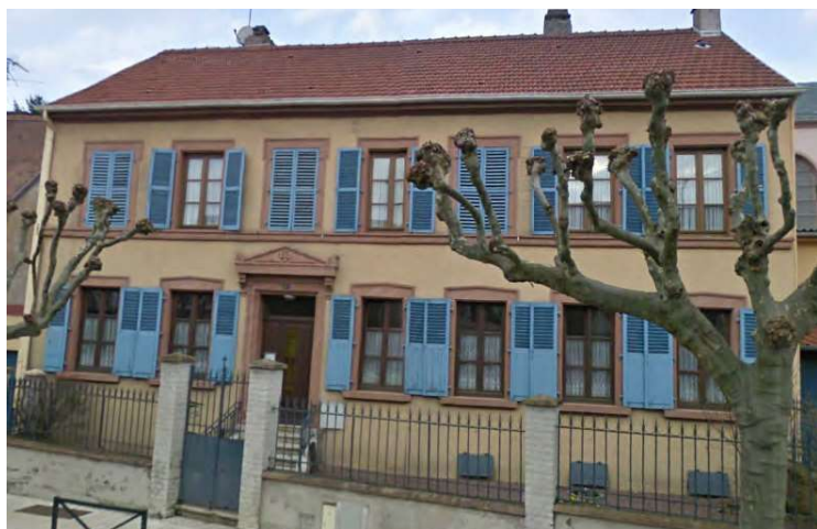
n°171 rue du Maréchal Foch : toiture la plus courante (à 2 pans avec forte pente et faitage parallèle à la rue), couverte de tuiles mécaniques à doubles côtes de teinte rouge naturel.
