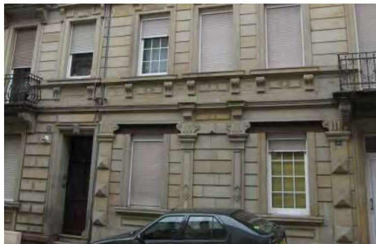
n°20 rue du Lycée
