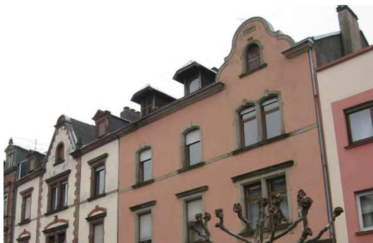
n°12-14 rue de la Blies
