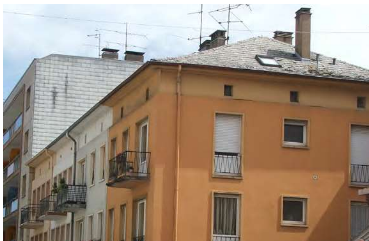
n°22 rue de l'Eglise : la couverture est réalisée en tuiles de fibrociment, matériau de couverture souvent utilisé sur les toitures des bâtiments de la Reconstruction.
