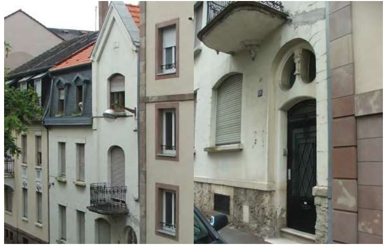
n°13 rue des Vosges (1909) : deux toitures différentes (avec faitage parallèle à la rue et l'autre perpendiculaire), dessus-de-porte cintré, percé d'oculi.
