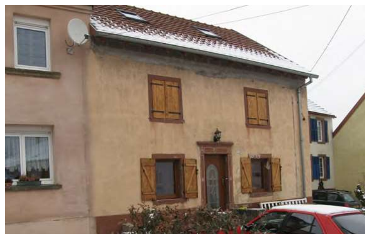
n°5 rue de la Fontaine (1835) : éléments de modénature en pierre (encadrement des baies et de la porte avec linteau-entablement et jambage peints).
