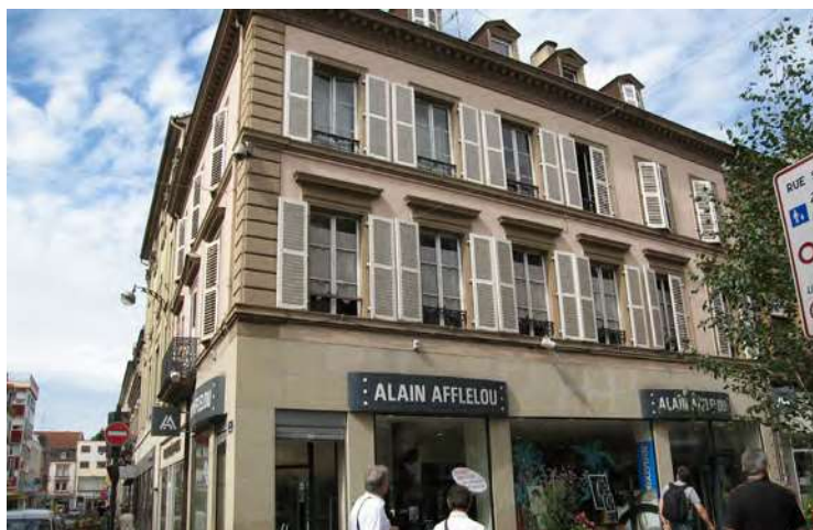
n°2 rue de la Chapelle : tous les éléments de modénature en pierre sont réalisés en grès beige laissé naturel (ni enduit, ni peint).
