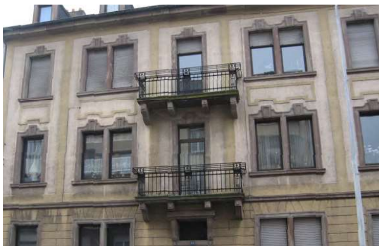
n°17 rue Clémenceau
