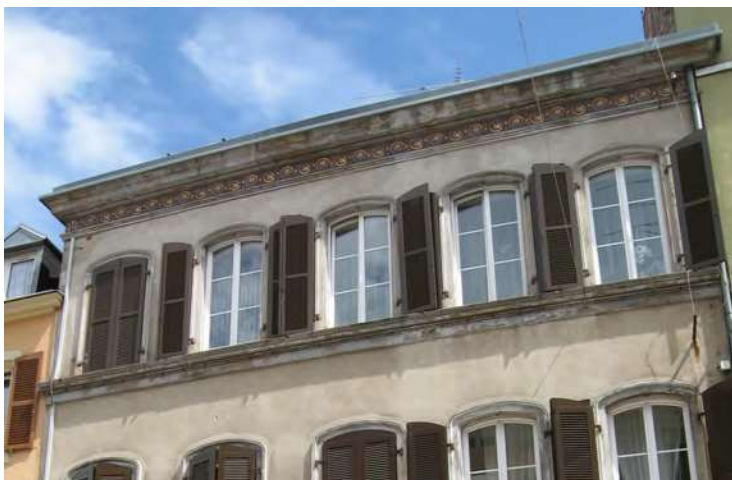
n°8 rue de Verdun : la frise peinte avec ses dorures, sous la corniche, fait partie des éléments de modénature à conserver et à restaurer.
