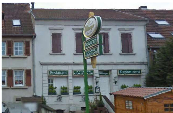
n°136 rue Foch : tous les éléments de modénature ont été réalisés en pierres de taille malencontreusement peintes.
