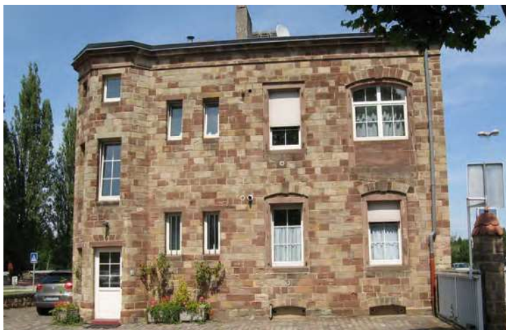
n°6 rue du Bac
