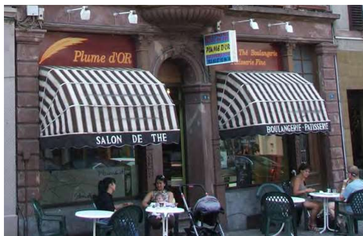
n°3-5 place du Marché : les stores-corbeilles pourront éventuellement être acceptés sur autorisation de l'architecte des bâtiments de France, à condition que ceux-ci ne portent pas atteinte à la qualité architecturale des rez-de-chaussée d'origine en pierre de ces immeubles.
