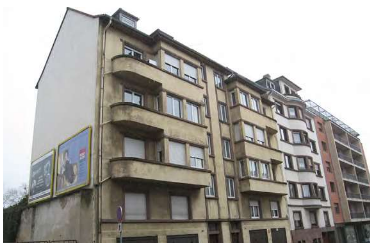
n°6-8-10 rue Clémenceau
