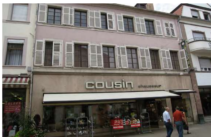
n°13 rue Sainte-Croix : l'accès indépendant aux étages de l'immeuble n'a pas été conservé (obligation de passer par le commerce) et les lettres de l'enseigne sont un peu grandes.
