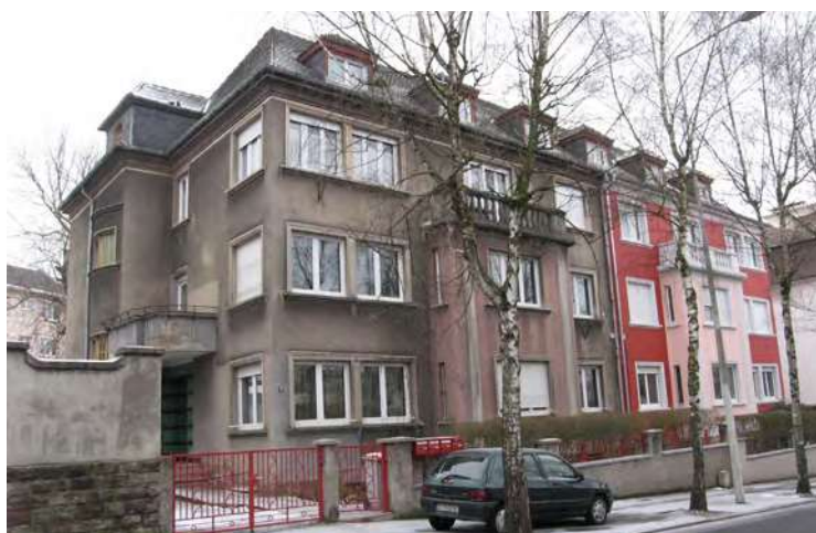
n°38-40 rue Clémenceau
