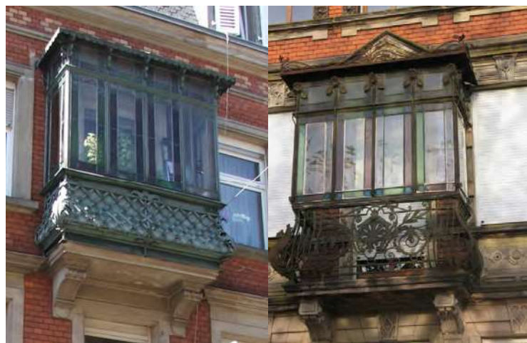
n°13 rue des Généraux Crémer & n°4 rue Jacques Roth
