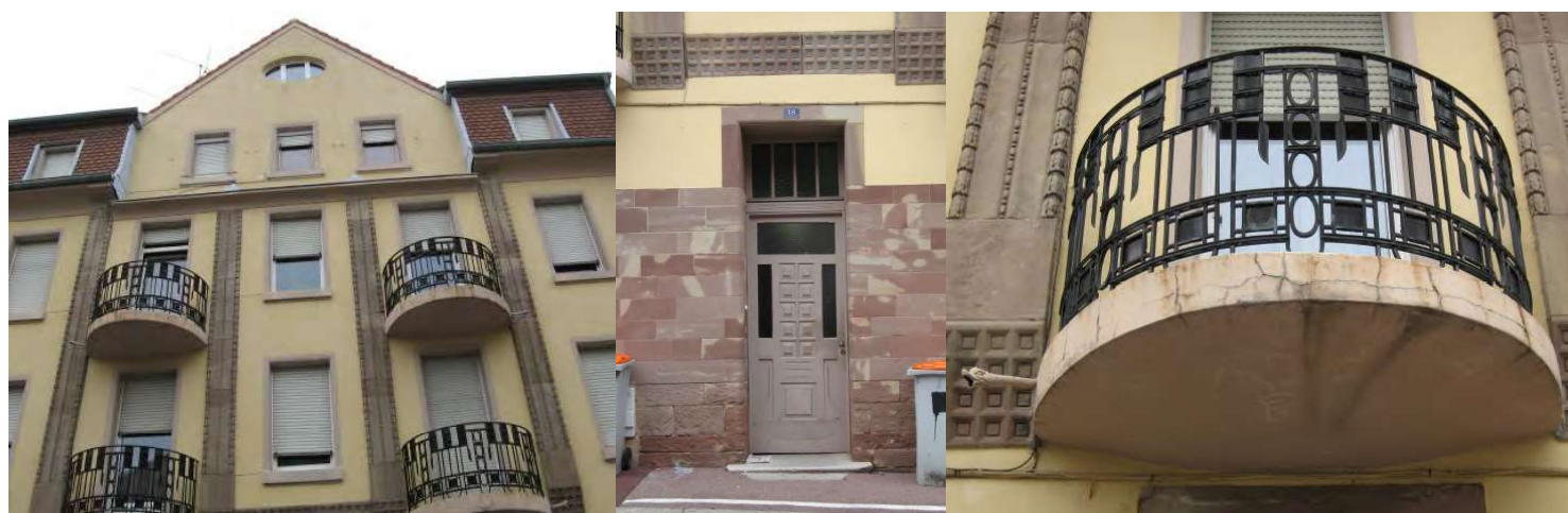
n°18 rue Pauline, Theodor Fischer architecte. (détail porte et balcon)
