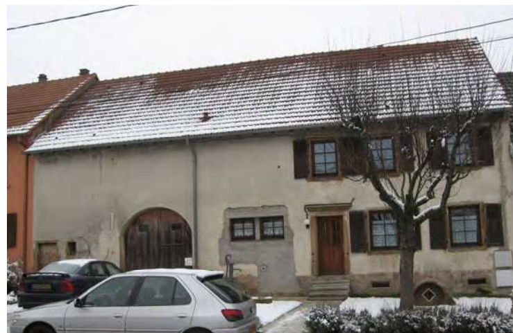
n°6 rue du Groupe Scolaire : ferme de taille moyenne regroupant sous un même toit la partie grange et la partie habitation. La forme cintrée de la porte de grange est encore d'origine.
