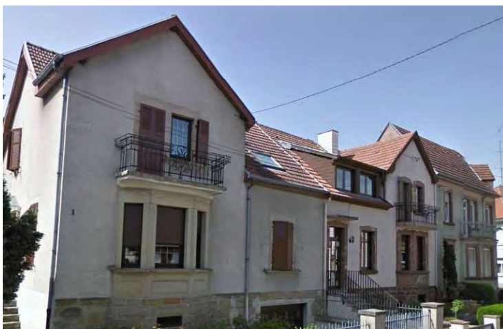
n°1-3-5 rue du Petit-Paris : façade mixte avec pignon sur rue (2 toitures à 2 pans, l'un avec faîtage perpendiculaire à la rue, et l'autre avec faîtage parallèle).
