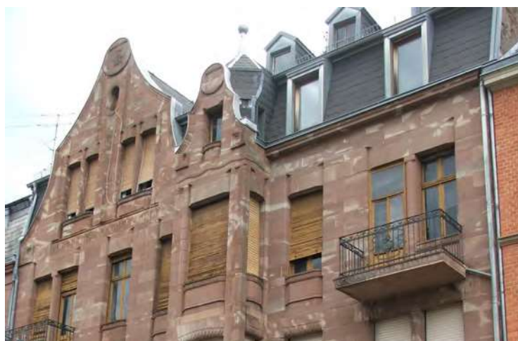
n°5 place Sibille (1908) : ardoises schuppen sur brisis, clocheton et jouées des lucarnes.
