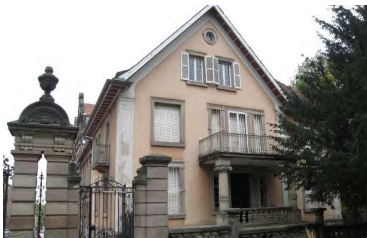
n°45 rue du Parc (Villa Brühne) : son entrée, située en pignon et donnant sur le parc municipal, se fait par un porche couvert par un balcon soutenu par deux colonnes aux chapiteaux ioniques.
