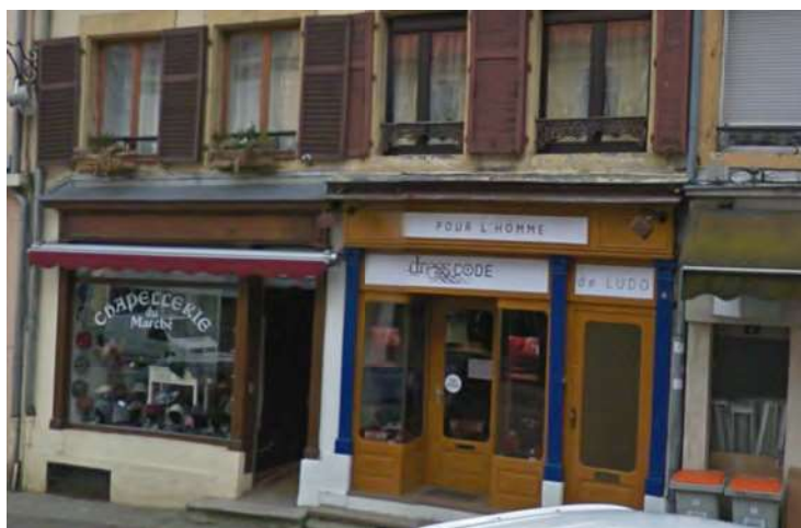
n°8-10 place du Marché : exemple d'une devanture en bois à Sarreguemines (parmi les bâtiments répertoriés) qui est en fait un mélange hybride avec ses poteaux en fonte.
