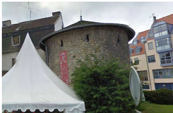
n°17 rue des Moulins : ancienne tour médiévale réalisée en moellons apparents.
