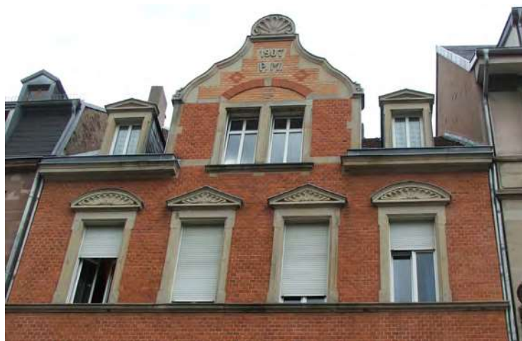
n°7 place Sibille (1907) : toiture avec grand volume saillant, formant fronton.
