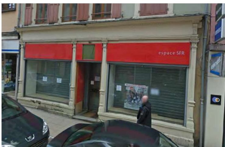
n°3 rue de Verdun : l'accès indépendant aux étages de l'immeuble depuis le domaine public n'a pas été conservé (obligation d'entrer dans le commerce pour accéder aux étages).
