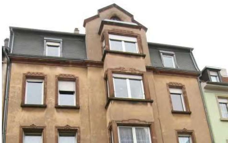
n°13 rue du Lycée
