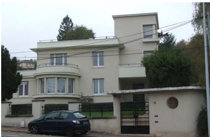
n°34 rue des Muguets (1939), Théophile Dedun architecte.
