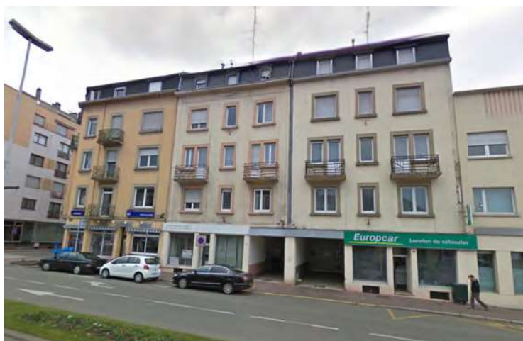
n°15-17 avenue de la Gare : une toiture à pans brisés avec terrasson et brisis recouvert d'ardoises rectangulaires, à conserver.
