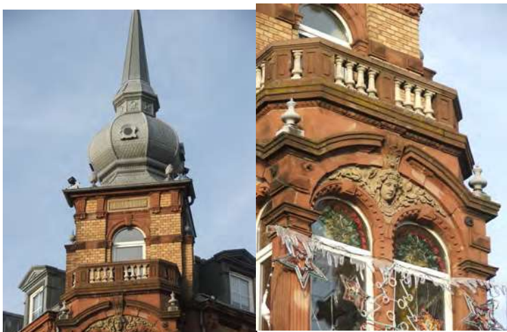
n°1 rue du Maréchal Foch, détails de toit et de modénature
