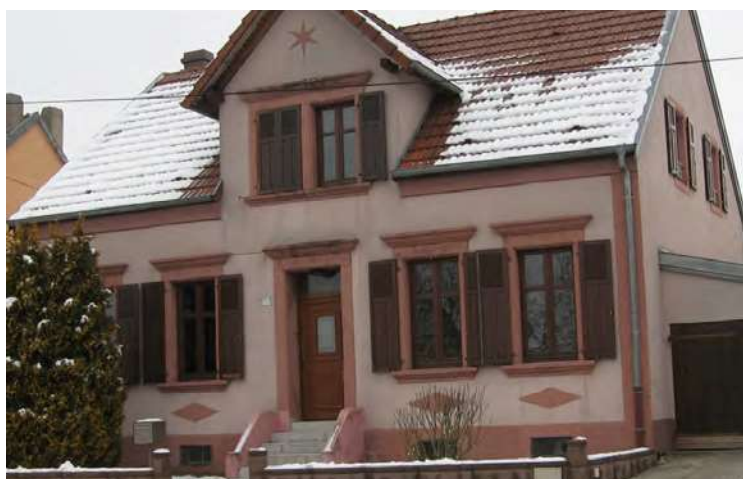
n°15 rue de Blies-Ebersing (type C1)
