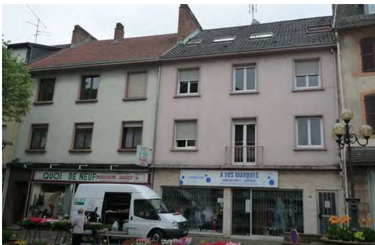
n°10-12 rue de l'Eglise (type F1) : l'architecture de la Reconstruction est souvent très sobre. Il conviendra donc, de préserver les éléments de modénature saillants en béton qui la caractérisent.
