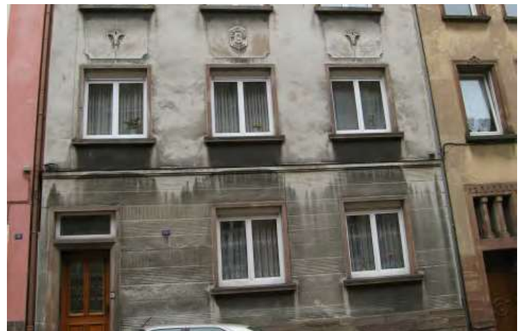
n°11 rue du Lycée
