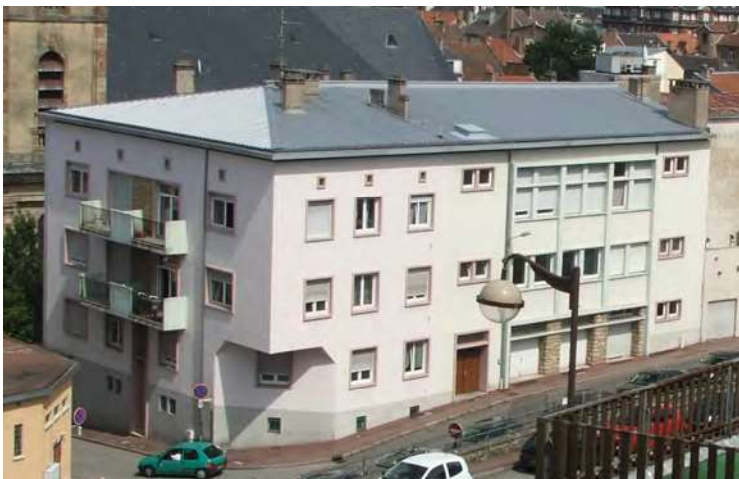
Immeuble au n°3 rue Saint-Nicolas, vue de la rue des Frères : la couverture est réalisée en zinc à joints debout.
