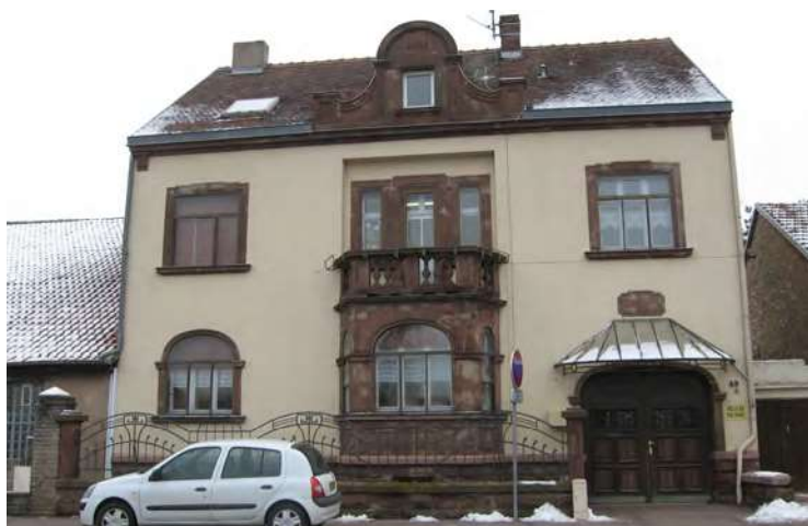
n°49 rue de Bitche : baies carrées avec encadrements en grès rose de modèle récurrent sur les maisons de cette période, de même que le bow-window couronné d'un balcon avec balustrade en grès rose.
