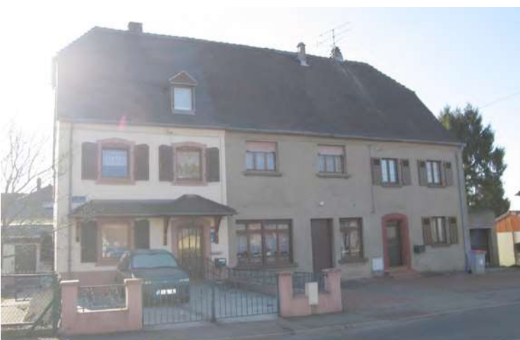
n°38-40 rue de Graefinthal (Neunkirch) : plusieurs façades de ces maisons ont été transformées (modifications de la taille et du format des baies).
