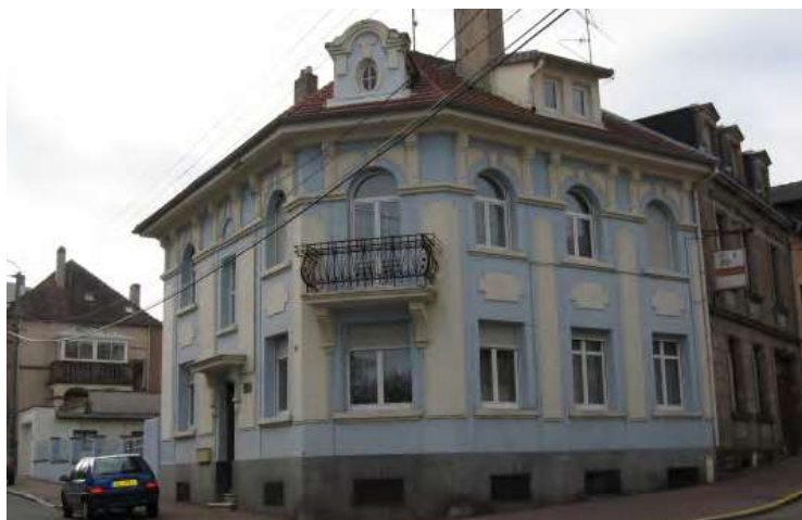
n°2 rue Lamartine : exemple d'une teinte bleu pastel possible, couleurs subordonnées à la composition de la façade.
