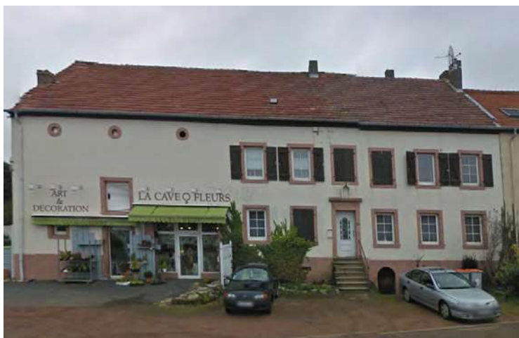
n°45 rue de Bitche : grande ferme du XIX e siècle, restaurée récemment. L'état d'origine a été bien conservé, même la devanture commerciale installée sur une partie du RDC respecte les baies existantes.
