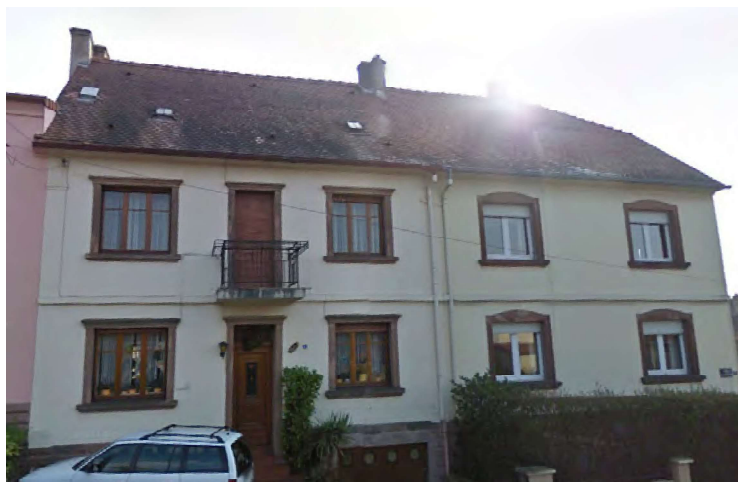
n°2-4 rue des Tirailleurs : modèle de fenêtre d'origine, à 3 vantaux avec petit-bois imitant une traverse d'imposte.
