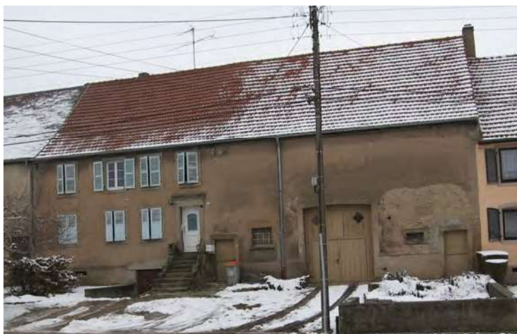
n°15 rue de la Fontaine (type B3) : ces grandes fermes du XIX e siècle regroupent sous une même toiture la partie grange et la partie habitation. Les baies sont de format rectangulaire.
