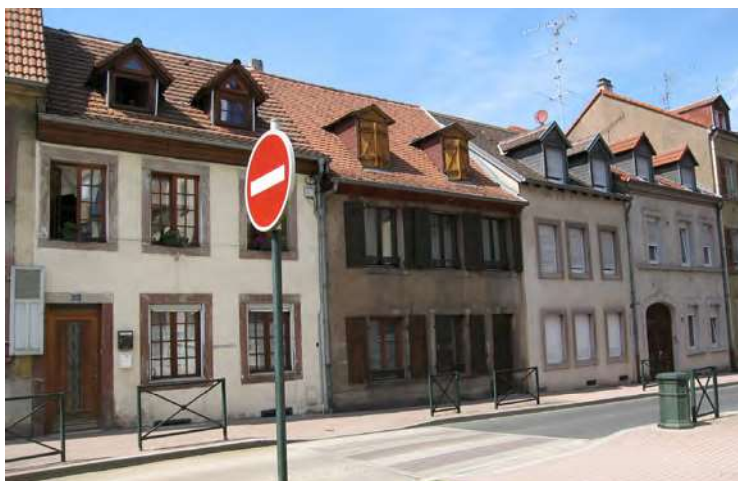
n°24-22-20-18 rue du Bac (type B1) : alignement de toitures à 2 pans, couvertes de tuiles biberschwanz avec lucarnes (modèles en bâtière). La plupart de ces maisons possèdent des volets roulants.
