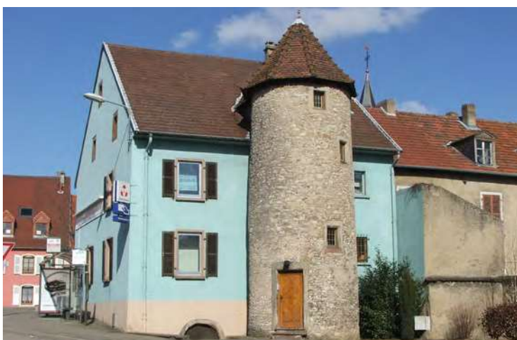
n°1 place du Chanoine Kirch : ancienne tour de péage au XVII e siècle, réalisée en moellons de calcaire recouverts d'un enduit à pierre-vue et récemment restaurée.
