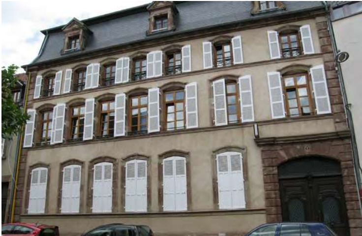
n°6 rue d'Or : le modèle des volets battants en bois est à persiennes aux étages et mixtes au RDC (au 2/3 plein avec grands cadres en bois en partie basse et persiennés en partie haute).
