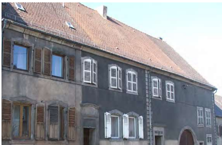
n°14 rue de Grosbliederstroff : exemple de toiture traditionnelle couverte de tuiles plates (biberschwanz).
