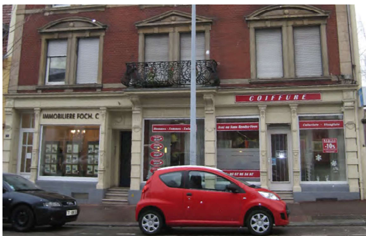
n°9 rue du Maréchal Foch : un rez-de-chaussée d'origine parfaitement conservé avec ses 2 commerces et la porte indépendante d'accès à l'immeuble, centrée en façade.
