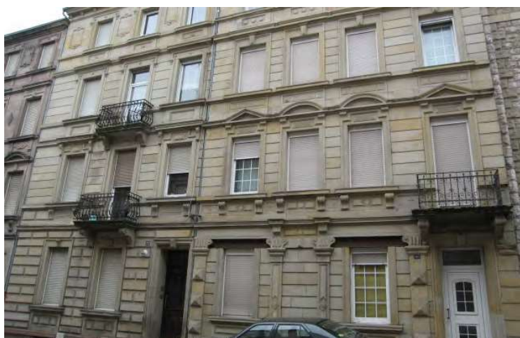
n°20-22 rue du Lycée
