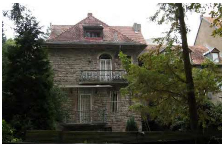
n°45 rue du Parc (façade arrière)
