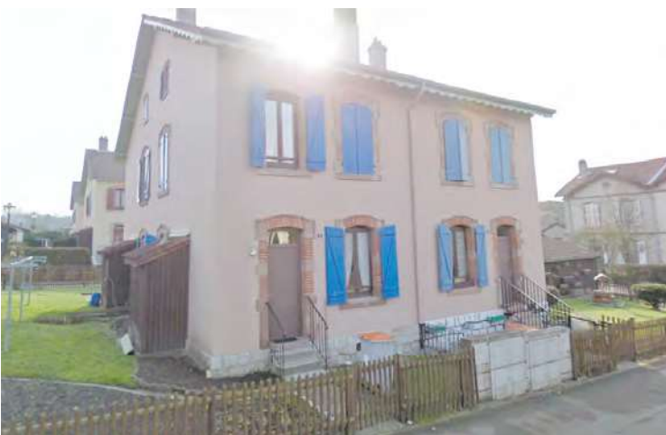
n°1-3 Cité 1 ère Avenue (Cité des Faïenceries, 1869) : les éléments de modénature (essentiellement les encadrements des baies) sont réalisés en briques rouges et en pierre (grès rose).
