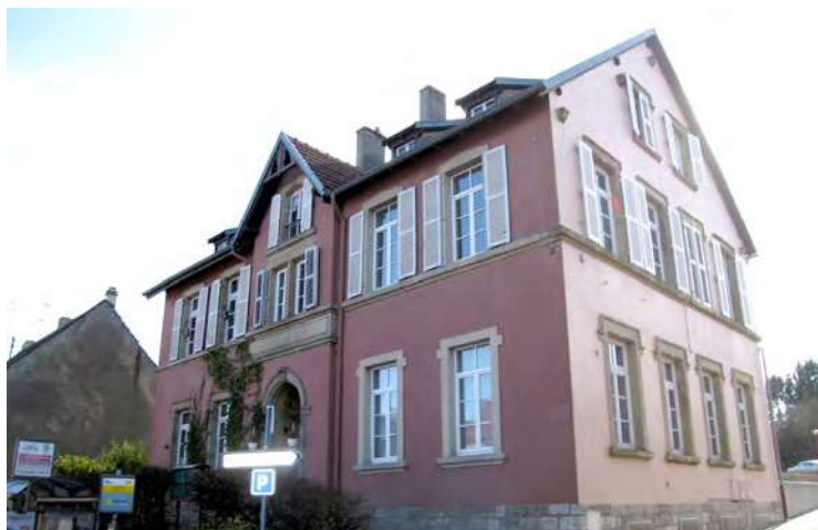
n°161 rue de France
