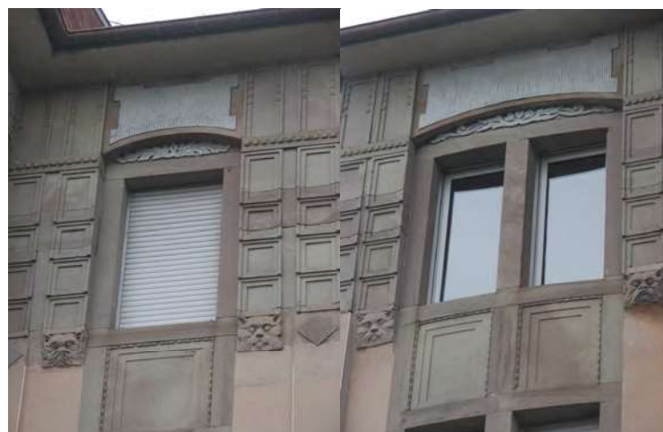
n°34 rue Alexandre de Geiger (1905), détails de modénature.
