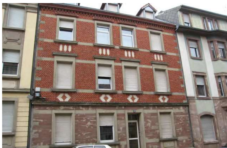
n°19 rue du Lycée
