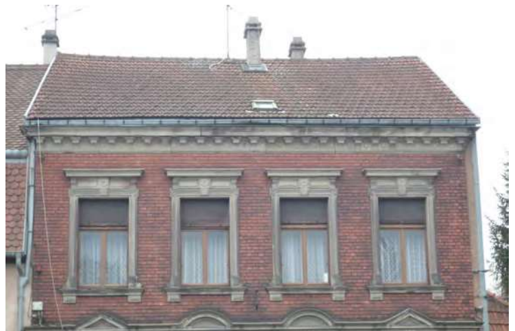
n°17 rue du Bac (1910)
