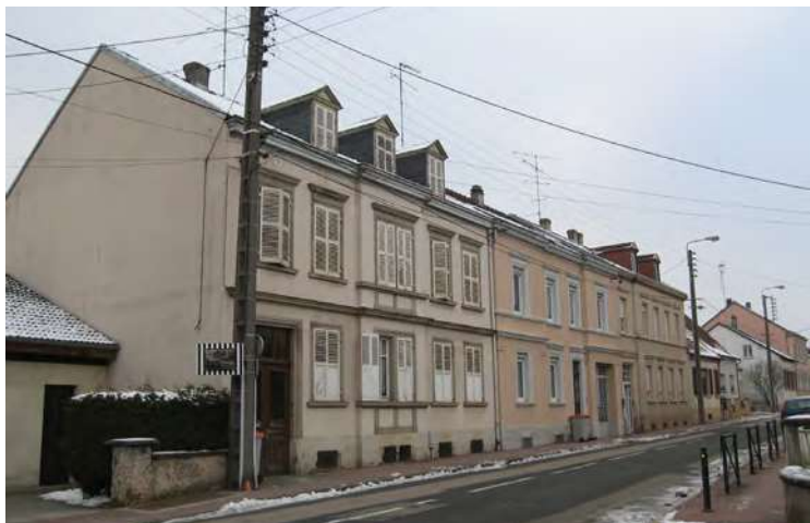
n°25-27-29 rue des Romains (type B2) : maisons bourgeoises aux façades et aux toitures alignées. Certaines possèdent des lucarnes de toit (modèles à fronton).
