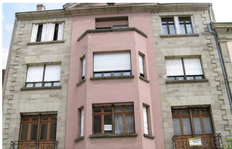
n°4-6 rue Ste-Croix : la façade est entièrement réalisée en appareillage régulier de pierres de taille (grès beige) laissé naturel, seule la partie centrale du bow-window a été peinte.
