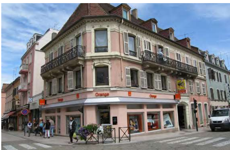
n°1 rue Charles Utzschneider : grand linéaire de façade, aux travées très régulières et ordonnancées, limitées à R+2. La pierre de taille utilisée est du grès gris-beige qui a été peint en beige clair.
