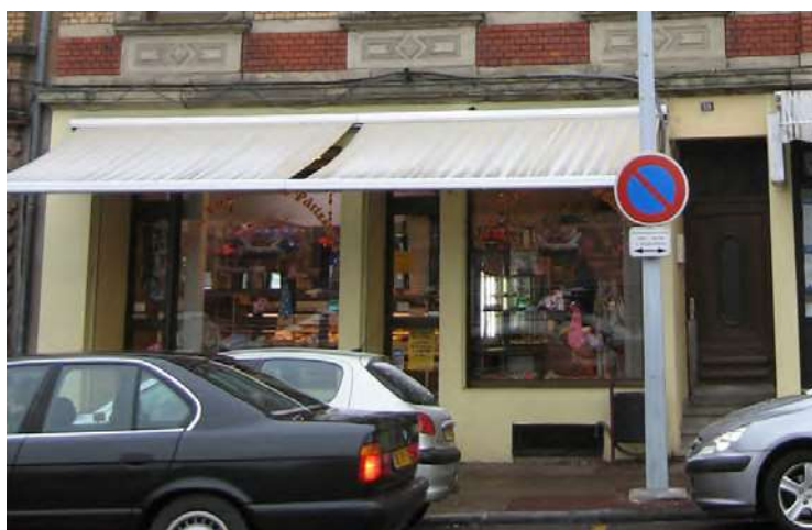
n°59 rue du Maréchal Foch (devanture en feuillure avec rez-de-chaussée modifié)
