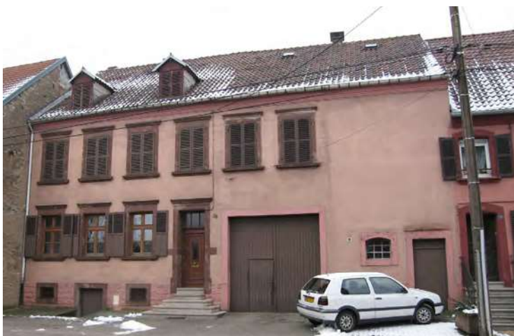
n°28 rue de Bitche : les encadrements des baies et de la porte d'entrée sont réalisés en grès rose (légèrement bigarré), laissés naturels, les autres ainsi que le soubassement sont peints.
