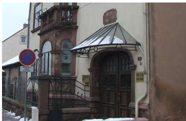
n°49 rue de Bitche : baies carrées avec encadrements en grès rose de modèle récurrent sur les maisons de cette période, de même que le bow-window couronné d'un balcon avec balustrade en grès rose.
