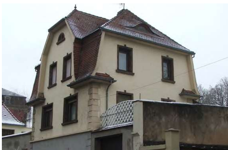
n°42 rue du Maréchal Foch : les différences par rapport aux autres maisons de sa catégorie : volumétrie, toiture, couverture, lucarnes, finition de l'enduit.
