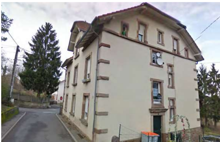
n°7 Closerie des Lilas : maison en série de type 2 Les antennes paraboliques devront être invisibles du domaine public (interdites en façades).
