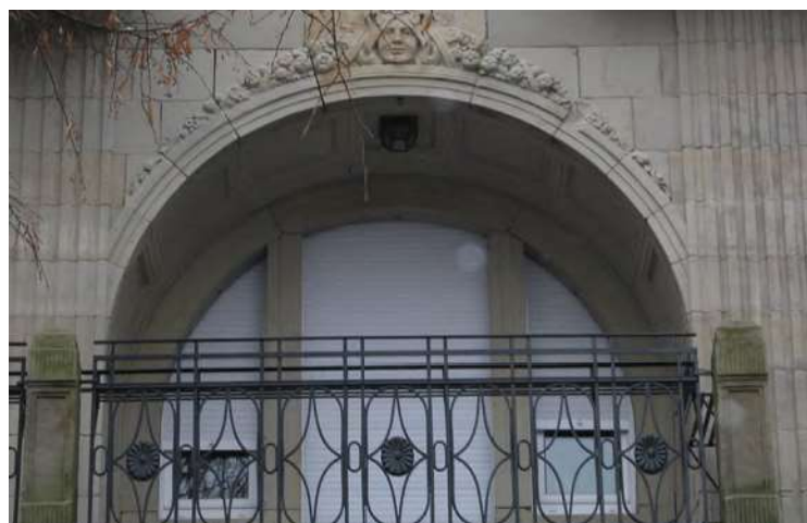
n°6 square Thomas Wilson, détails de loggia et du balcon
