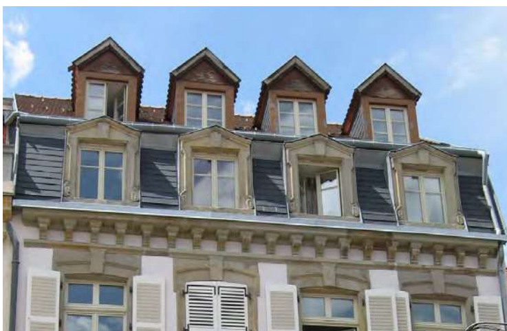
n°15 place du Marché : couverture sur brisis en ardoises rectangulaires posées à la française et lucarnes frontons. Couverture en tuiles plates (biberschwanz) traditionnelle sur terrasse avec lucarnes en bâtières.
