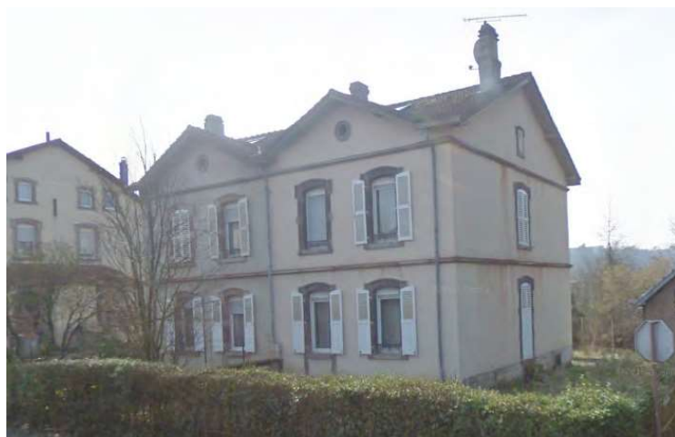
n°6-8 rue Edouard Cazal (Cité des Faïenceries, 1869) : cette maison jumelée est dotée de 2 avant-corps avec pignon en façade avant, les entrées s'effectuant latéralement en pignons.
