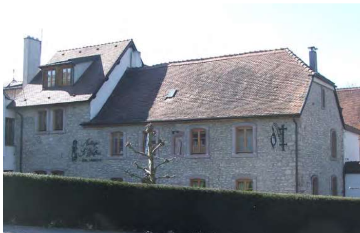
n°2 rue des Sports : l'Auberge St- Walfrid existait déjà en 1711 comme annexe du Prieuré. Après la Révolution, la ferme devient une auberge pour les charretiers halant les péniches du Canal de la Sarre.
