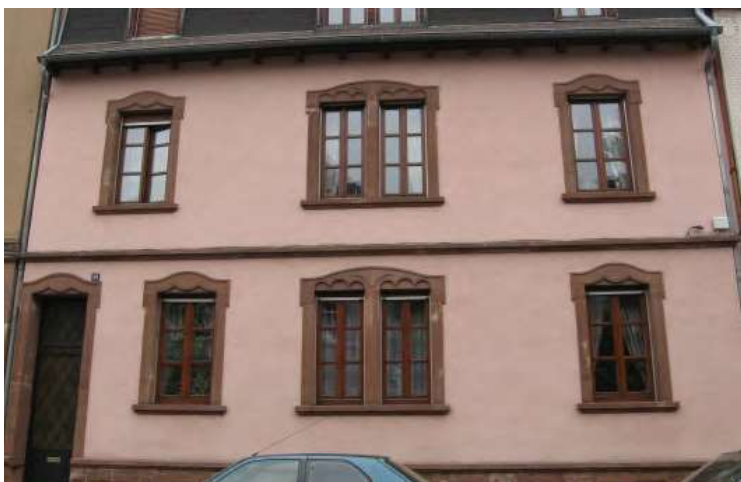
n°33 rue des Muguets (type D1) : modèle de fenêtre à 2 vantaux avec une partition de 3 carreaux par vantail, assez rare (typique du XVIII e et XIX e siècle).
