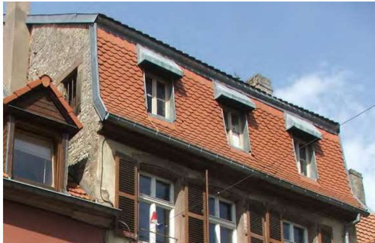
n°14 rue de France : couverture sur brisis en tuiles plates traditionnelles (biberschwanz) et lucarnes rentrantes.
