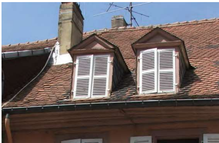
n°16 rue d'Or (type A1) : lucarnes en bâtière traditionnelles (hauteur du fronton équivalent à la moitié de la hauteur de la fenêtre, fronton en bois à panneau mouluré, couvert de tuiles plates biberschwanz, jouées en ardoises,)
