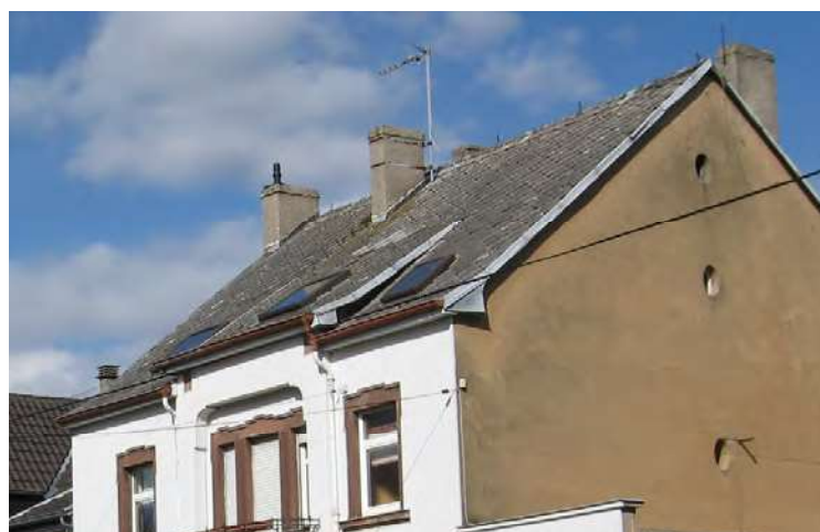
n°31 allée des Châtaigniers : couverture en tuiles de fibro-ciment et rives de toit en zinc.
