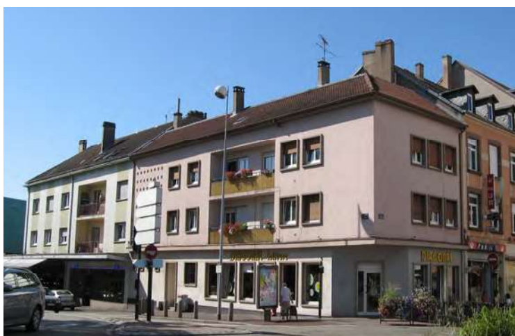
n°2 boulevard des Faïenceries (type F2)
