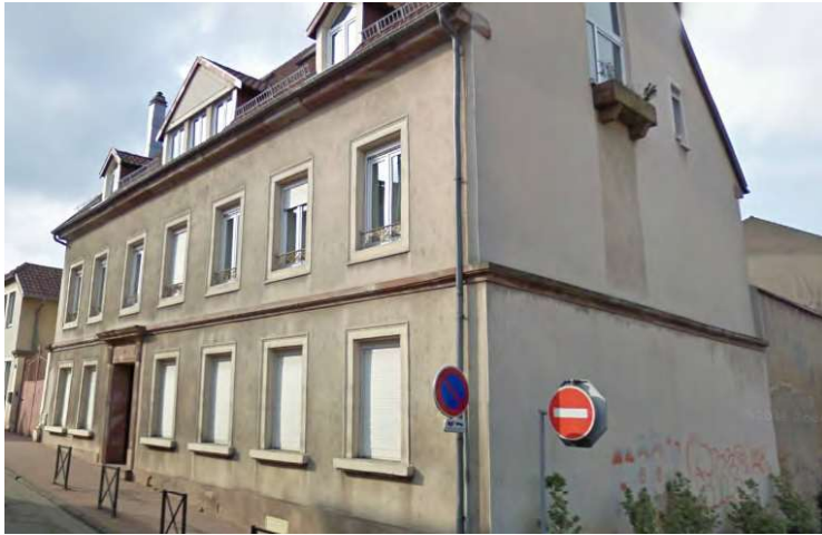
n°10 rue de la Montagne : rares sont les éléments d'origine conservés (forme des baies, bandeau horizontal, corniche et encadrement avec linteau de la porte d'entrée en pierre de taille).
