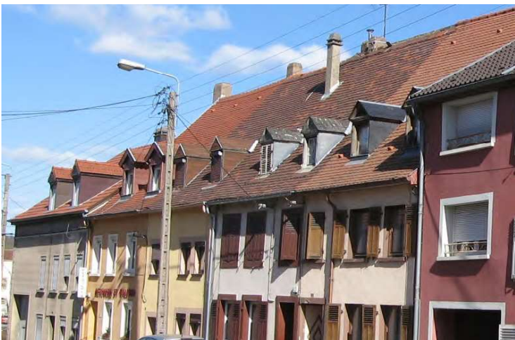
rue de Grosbliederstroff (type A1) : aucun châssis de toit, différents modèles de lucarnes en bâtière (d'origine, du XIX e et XX e siècle) tous alignés dans le tiers bas de la toiture et limités à 2 par pan.
