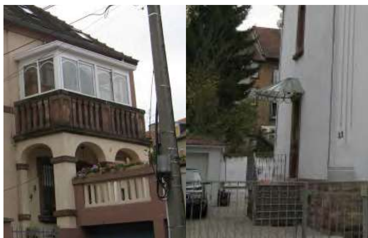
n°6 rue Lamartine : ajout d'une véranda sur un balcon avec balustrade en pierre d'origine, non autorisé.
