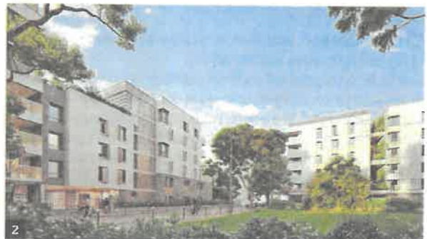
1 - Les déchets de démolition d'une ancienne résidence de l'îlot Brenu sont entrés dans la composition des granulats. 2 - Les deux nouveaux immeubles doivent être livrés au dernier trimestre 2024.
