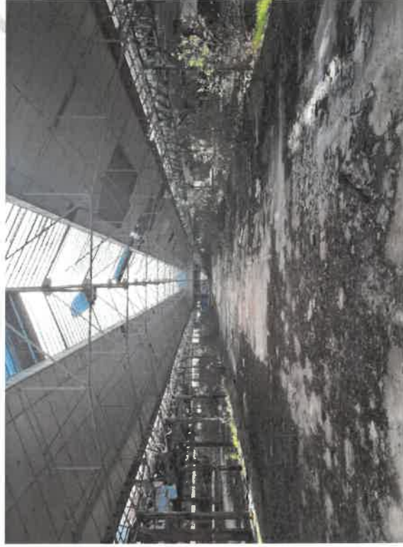
Ancien atelier constitué d'une structure métallique et d'une verrière
